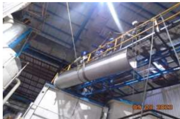
Imagen 2. Nivelación y acoplamiento del conductor helicoidal.
