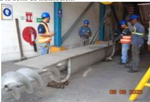
Imagen 1. Conductor helicoidal preparado para su instalación.
