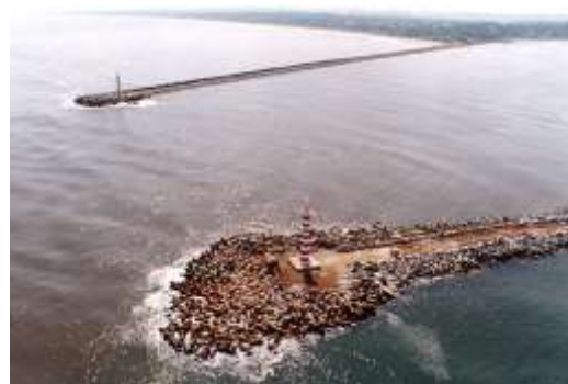
Figura 2. Ejemplo de escolleras del puerto de Coatzacoalcas, Veracruz. (Ramírez, 2009).
