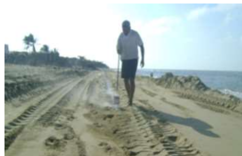
Figura 8. Figura donde se observa la limpieza del sitio de la protección playera, de igual manera el terreno nivelado y una persona colocando la línea de trazo donde será colocado el tapete anti socavación y el tubo geotextil.
