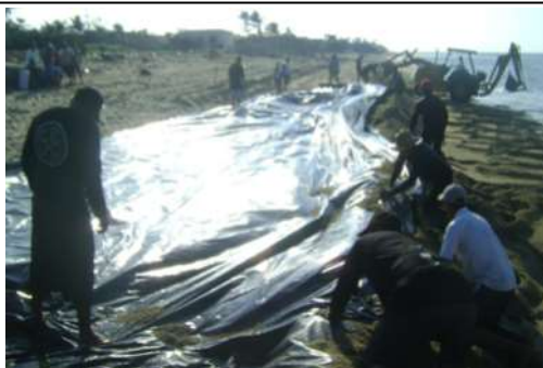
Figura 9. Colocado del tapete anti socavación en el área y longitud donde posteriormente se colocará el tubo geotextil.
