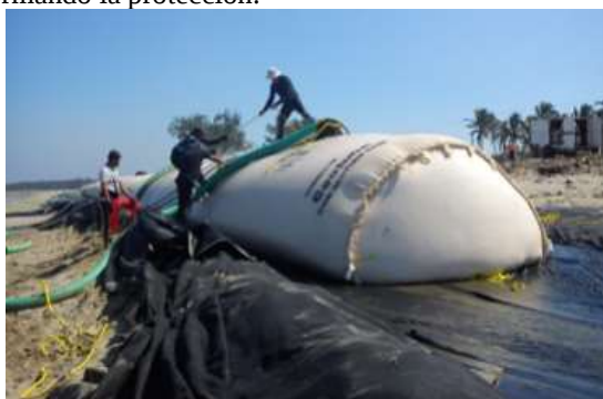
Figura 11. Se observa el tendido y colocación del tapete anti socavación y el llenado del tubo a base de tela geotextil encima del tapete. El relleno del material del tubo de tela geotextil se realiza con la bomba de 7.5 HP., y es a base de agua y arena. La arena se queda dentro del tubo, mientras que el agua sale del mismo.
