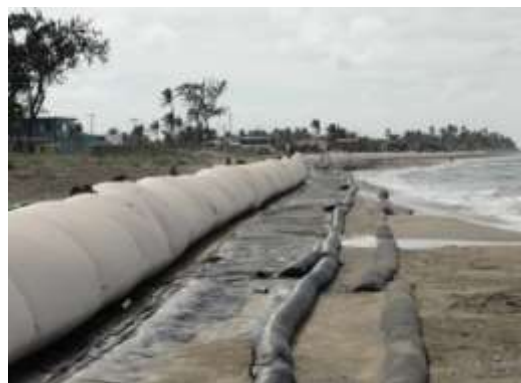
Figura 12. Tubos a base de tela geotextil encima del tapete anti socavación. Visualización del proyecto, avance y longitud de los mismos en la localidad de la obra.
