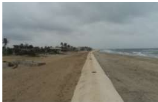
Figura 15. Figura donde se aprecia la conclusión de los trabajos pertenecientes a la protección playera con tubos a base de tela geotextil; además del relleno de arena en la playa antes de los tubos de tela geotextil.
