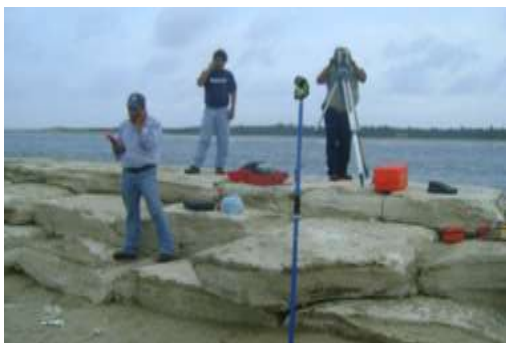
Figura 6. Figura donde se aprecia el inicio de las actividades de la obra con el levantamiento topográfico del lugar donde se realizará la obra en la comunidad de Sánchez Magallanes.
