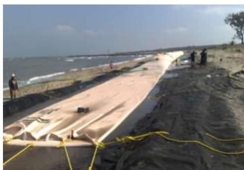
Figura 10. Figura donde se aprecia ya colocado el tapete anti socavación y se inicia la colocación del tubo geotextil para ser llenado con agua y arena.
