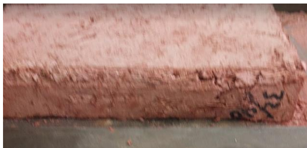
Figura 9. Ladrillo de mezcla 1, desmoronado después de prueba de compresión.
