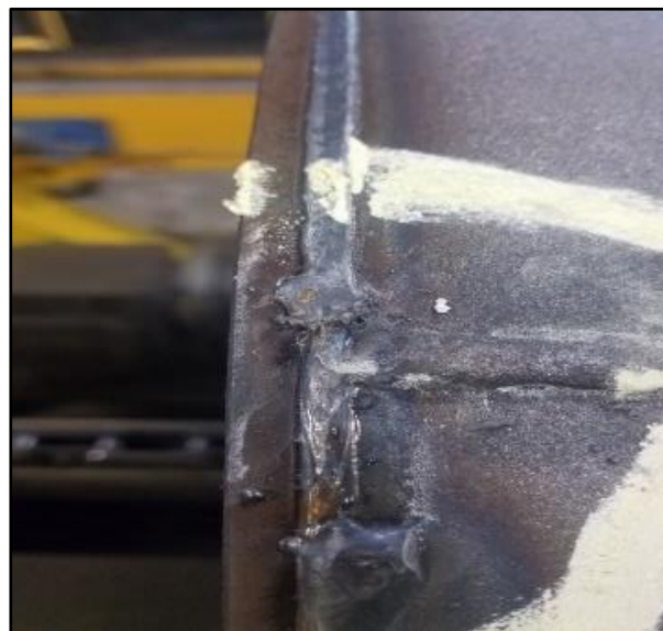
Figura 9. Defecto de soldadura por escurrimiento de vidrio.
