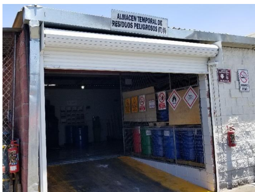
Figura 15. Letreros alusivos a la peligrosidad.
